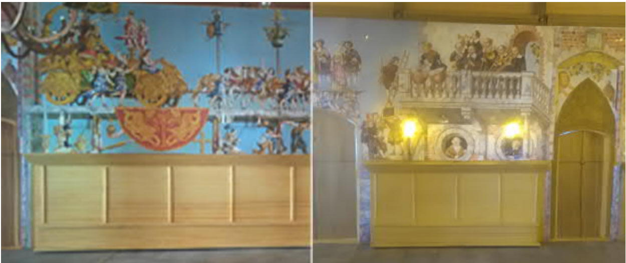
Zwei Ansichten der Nordseite des „Rathausaals“ © Rekonquista
